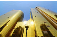
厦门现“土豪金”连体建筑
